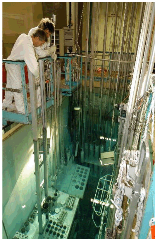
Techniciens récupérant des éléments de la "couverture fertile" d'un réacteur de ce type configuré en source plutonigène (transformant de l'U238 en Pu 239 par capture de neutrons)
